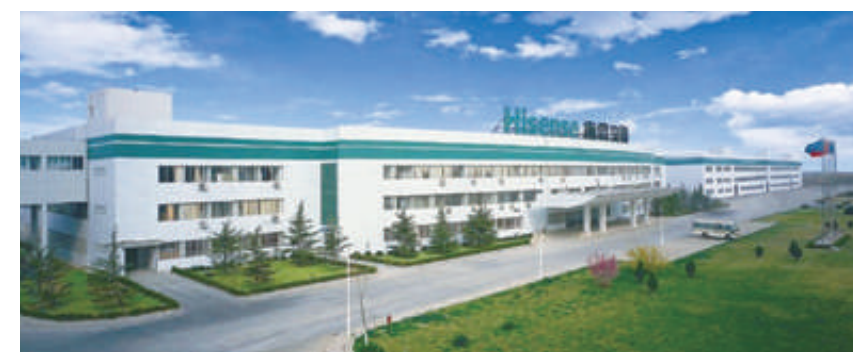
Hisense (Shandong) Air Conditioner Ltd., г. Циндао
